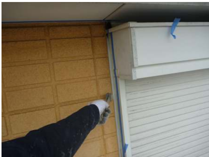
シーリング工事
