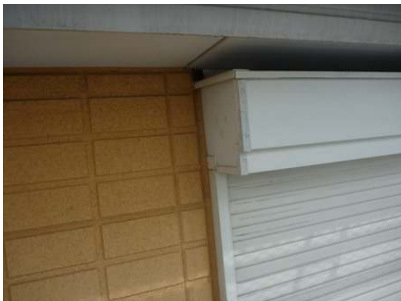
シーリング工事
