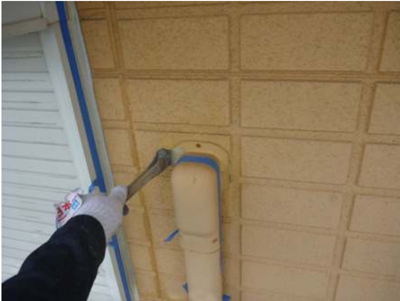
シーリング工事
