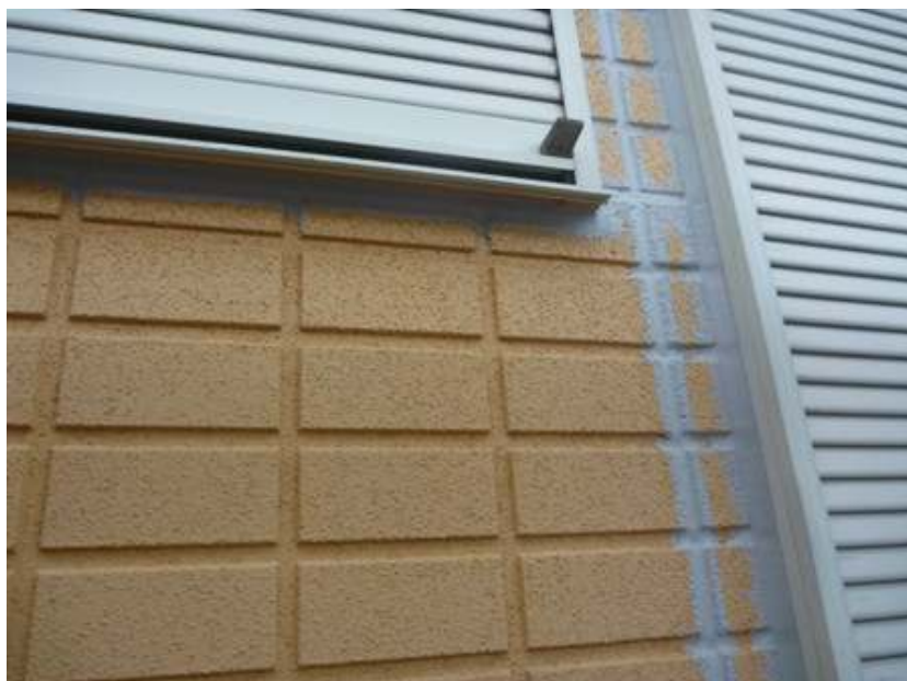
シーリング工事
