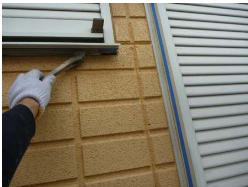
シーリング工事
