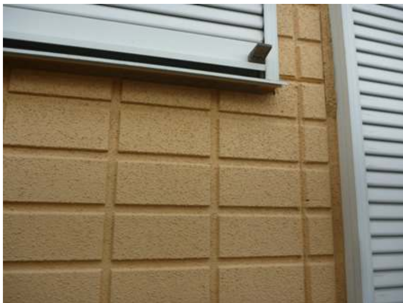
シーリング工事
