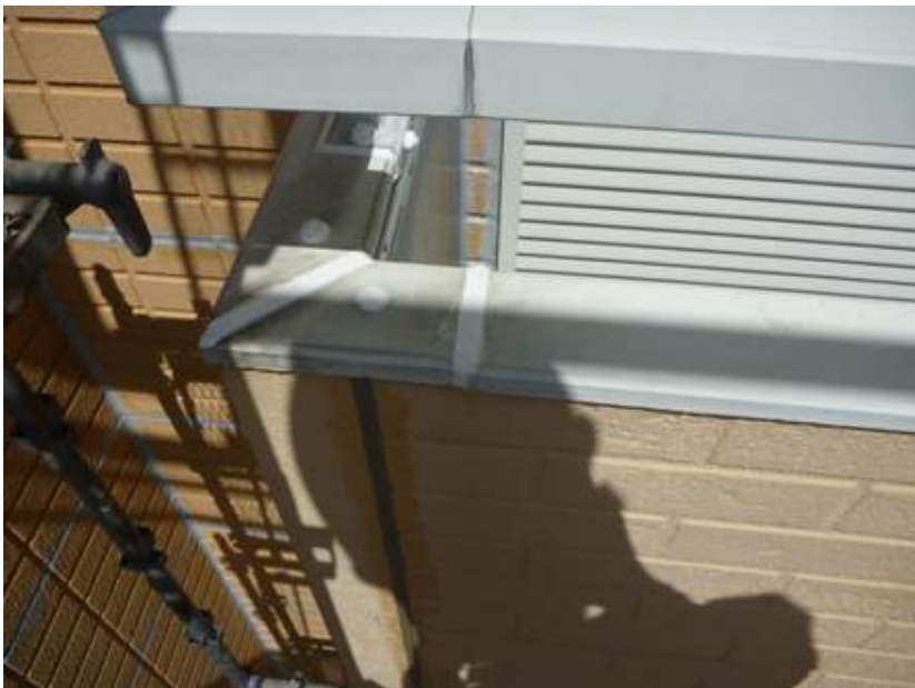
シーリング工事
