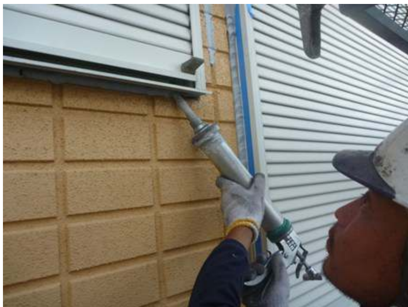
シーリング工事
