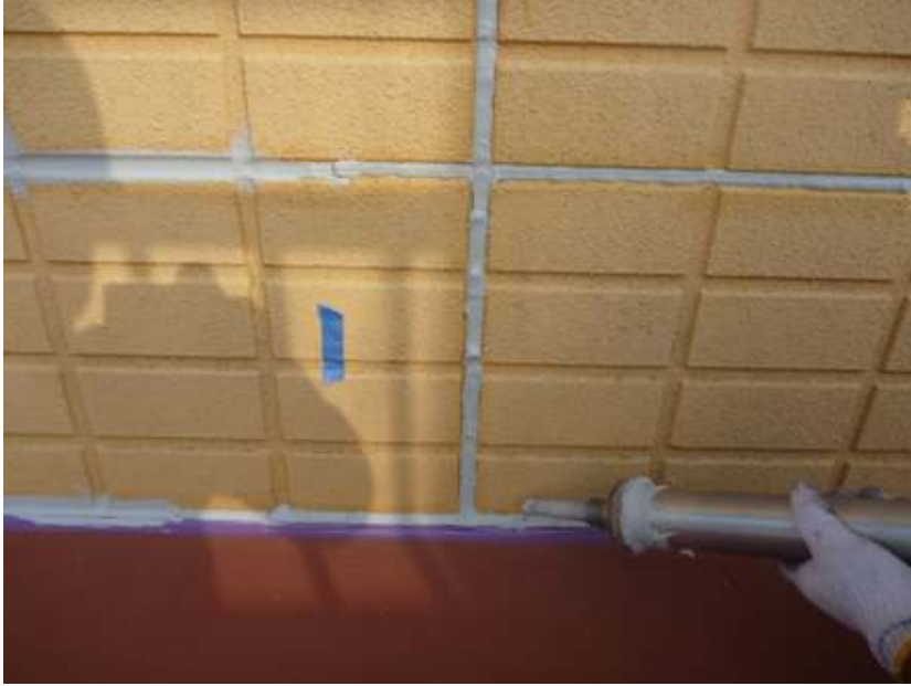
シーリング工事
