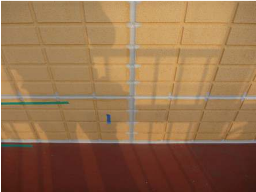
シーリング工事
