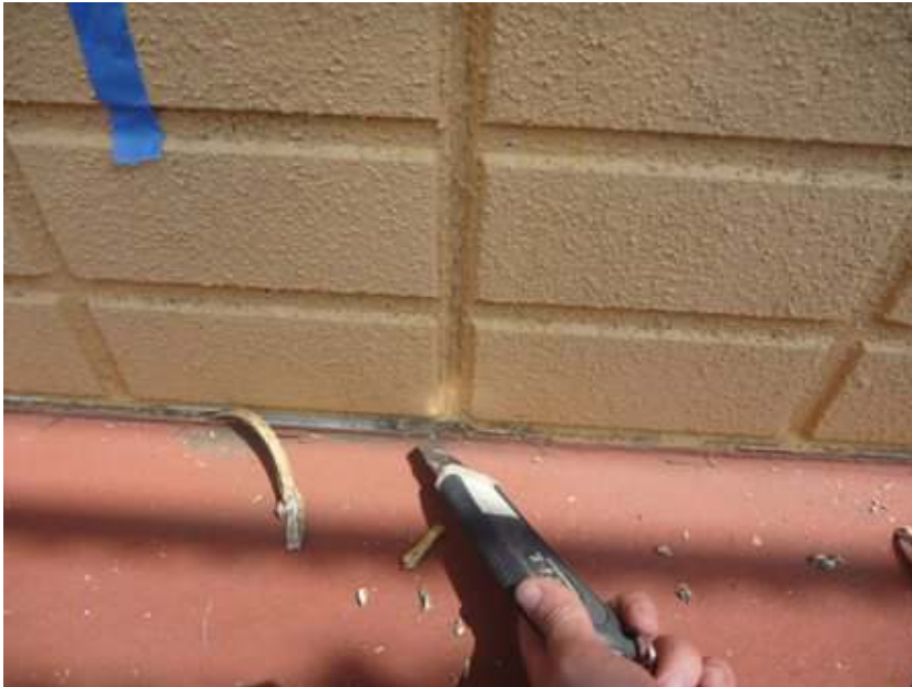
シーリング工事
