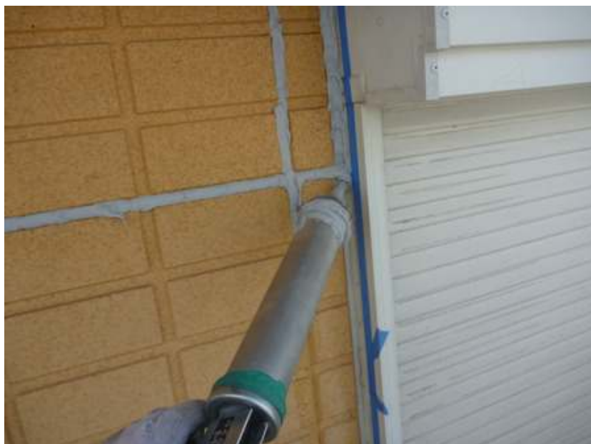
シーリング工事
