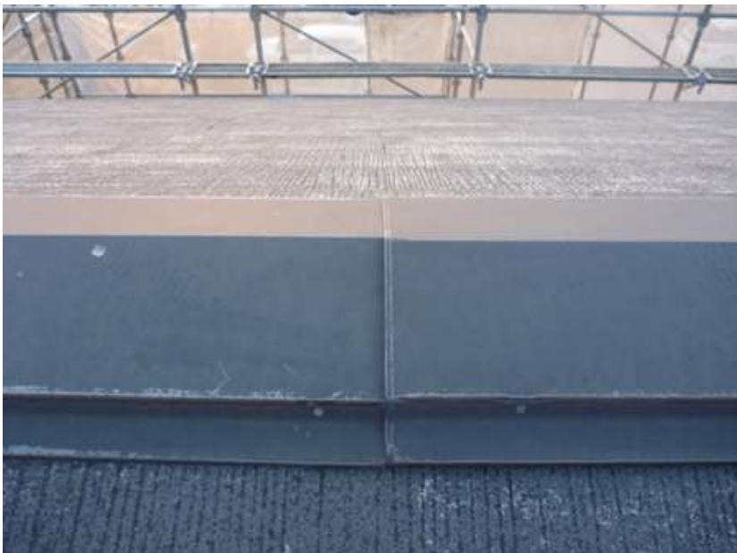
シーリング工事
