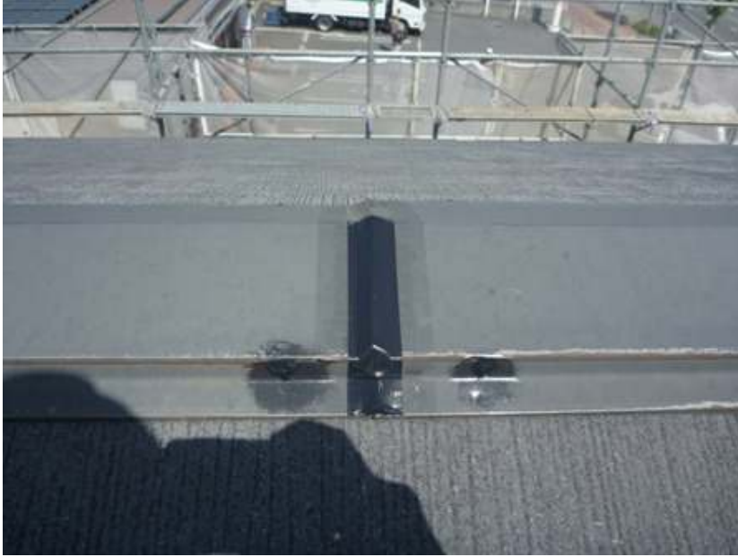
シーリング工事
