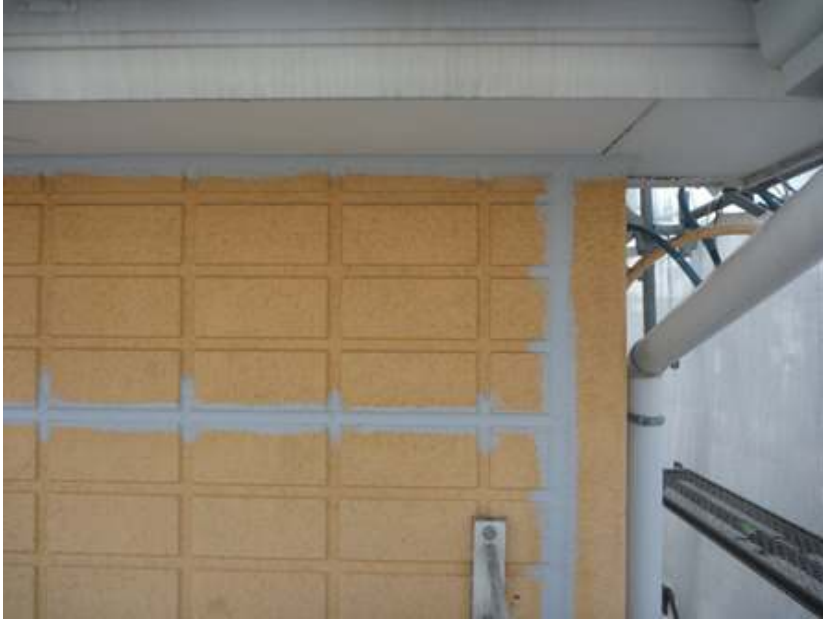
シーリング工事
