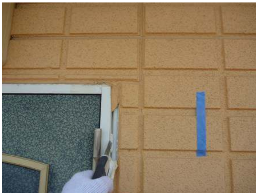
シーリング工事
