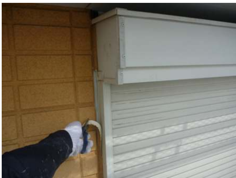
シーリング工事
