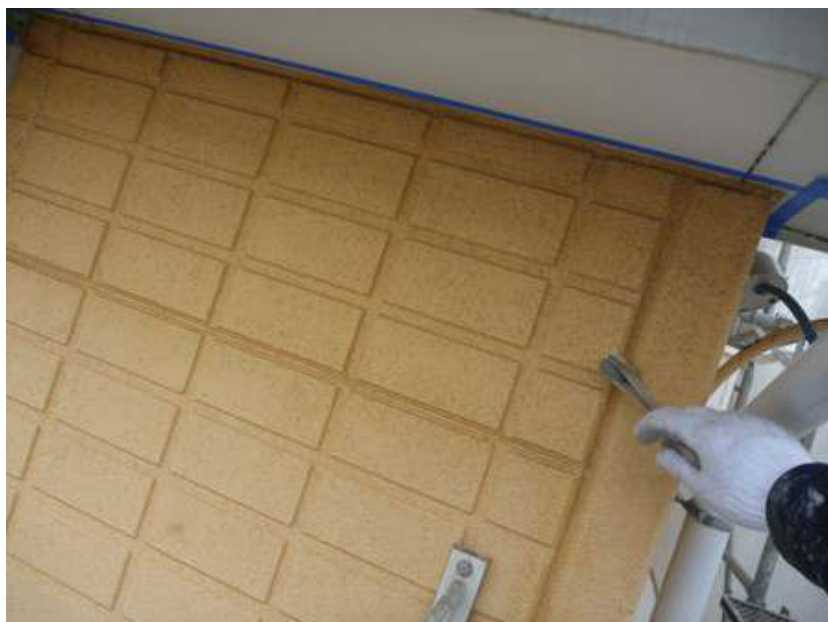
シーリング工事
