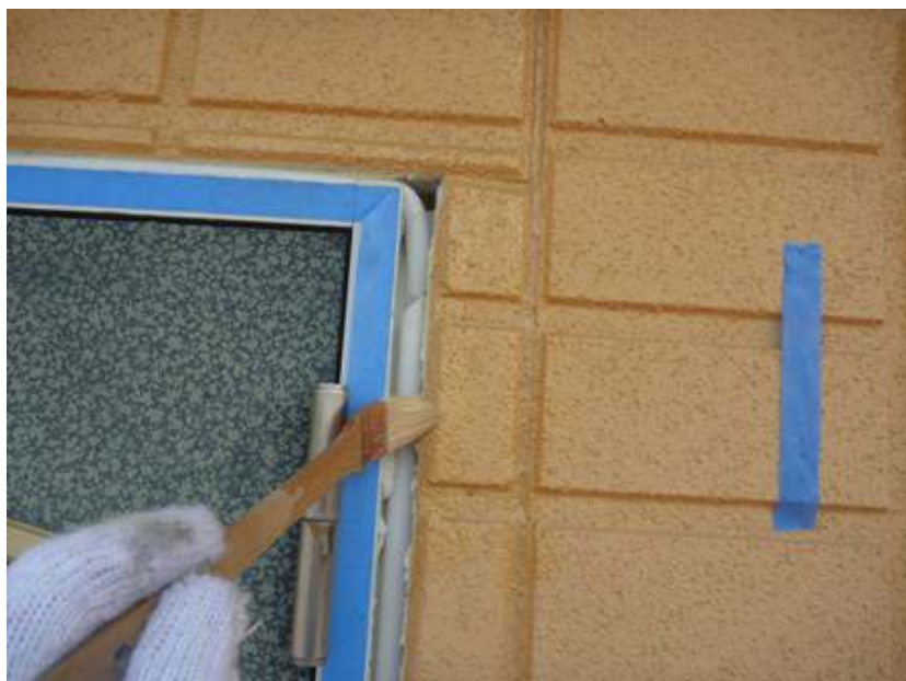
シーリング工事
