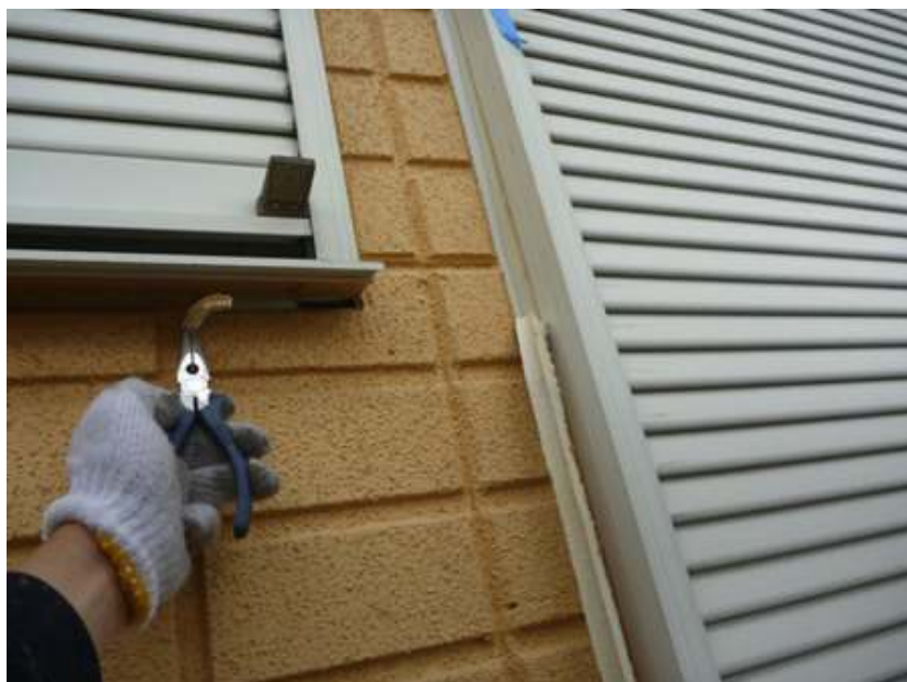
シーリング工事
