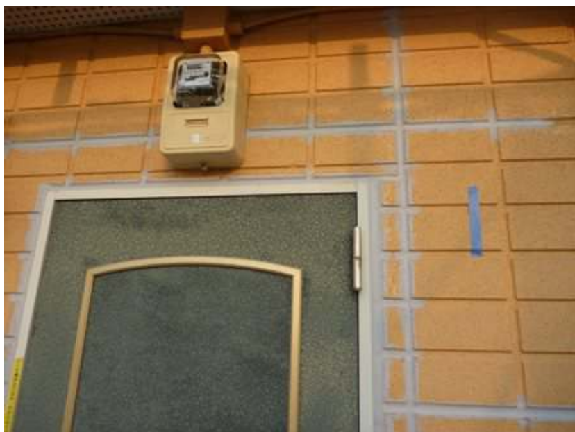
シーリング工事
