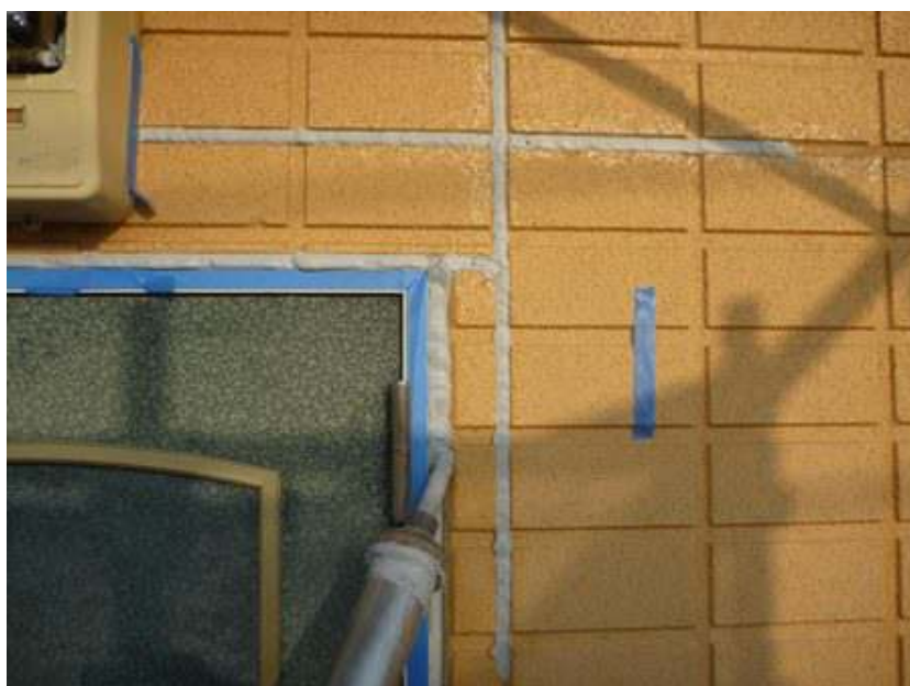
シーリング工事
