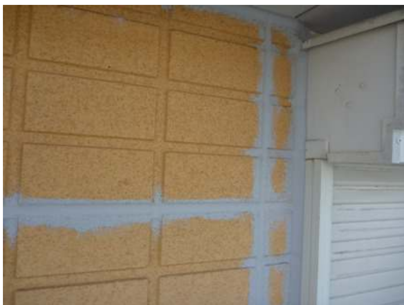
シーリング工事
