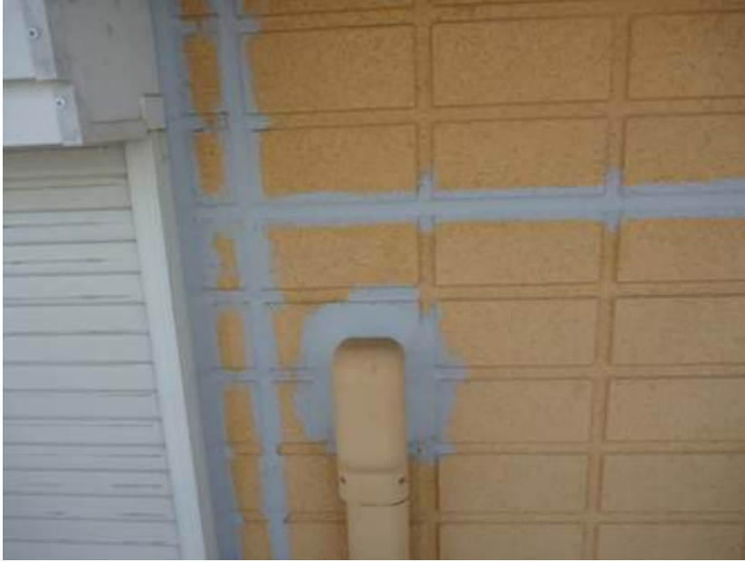
シーリング工事
