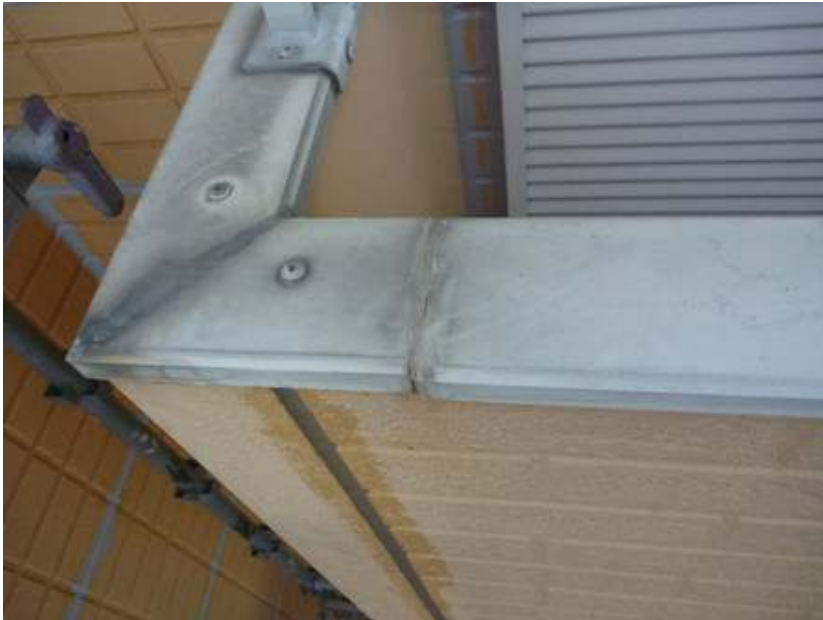
シーリング工事
