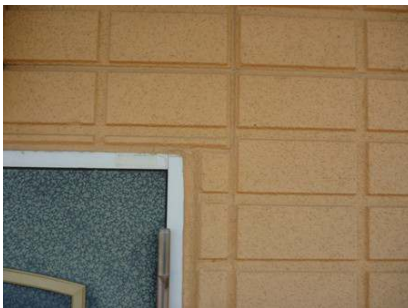
シーリング工事
