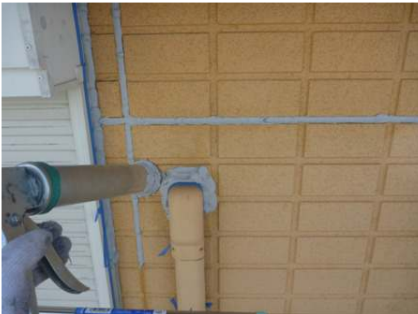
シーリング工事
