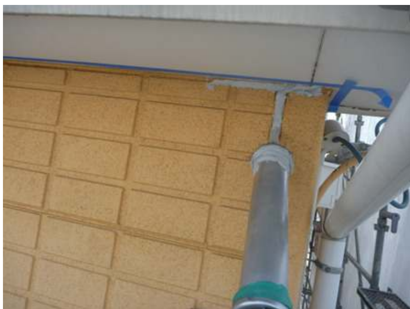
シーリング工事
